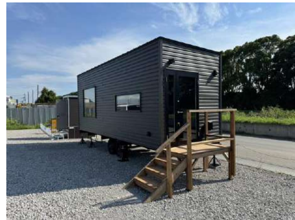
製造受注・設置の様子 1案件10棟1億円以上の 案件が増えています
