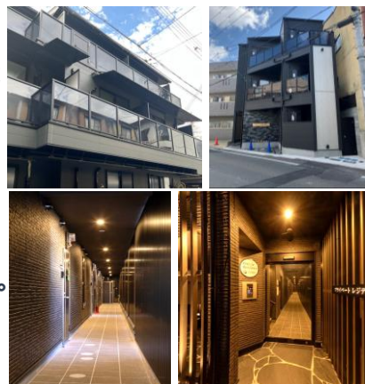
▲木三共外観・内観 木造のイメージを 払拭する外観とデザイン性に凝ったエントラ ンス・廊下で、入居者も施主からも「構造は 気にならない」と言われている。
