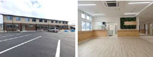
▲300坪33室の高齢者住宅完成写真 工期短縮 とコストダウンのため2×4工法で施工。2×4 工法のフレーマーが設計事務所から派遣され 在来の大工にアドバイスを実施している。
