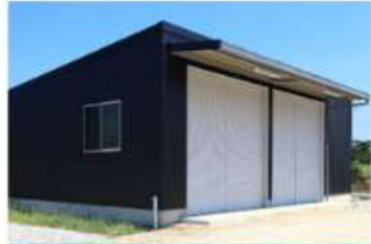
作業場・資材置き場
