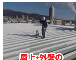
屋上・外壁の 遮熱・防水塗装
