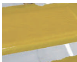
部材の補強塗装
