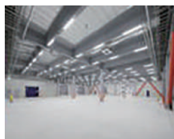
耐震診断・鉄骨補強
