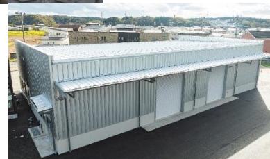
▼システム建築で施工した物件
