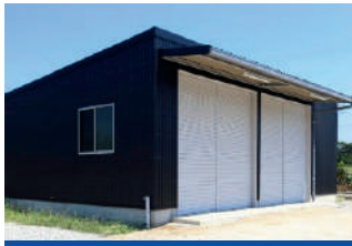
作業場・資材置き場
