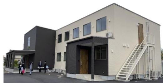
△障がい者向け住宅
