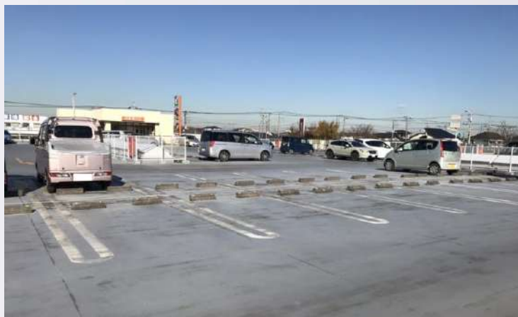
▲防水塗装の施工前
