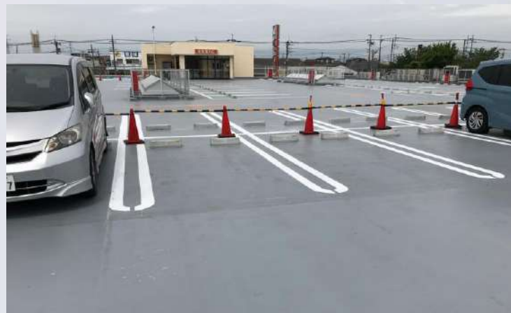
▲防水塗装の施工後
