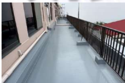
年間約15億円売上の防水塗装
