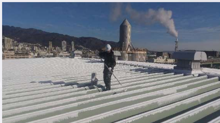
▲下塗りの様子プライマー塗布
