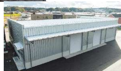
▼システム建築で施工した物件
