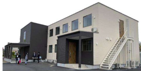
△障がい者向け住宅
