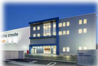
事務所倉庫実績
