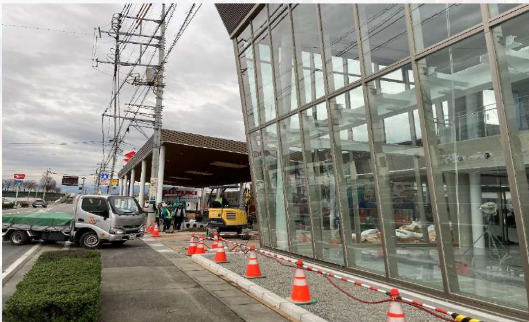
現店舗敷地内に建設中の新ショールーム
