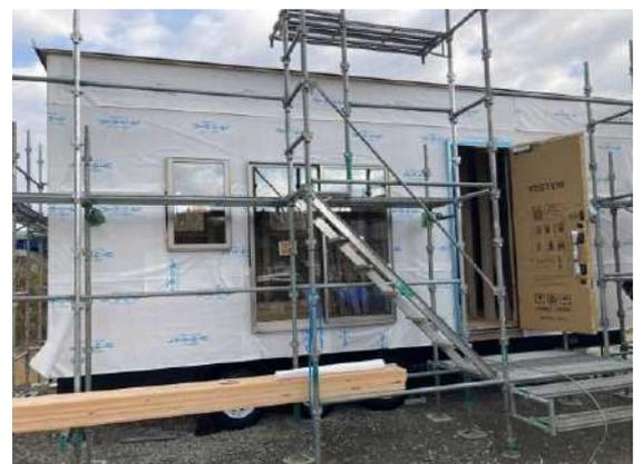
→ 製造場所（ヤード）の整備後に急ピッチで架台（シャーシ）を組み立て・設置した。
