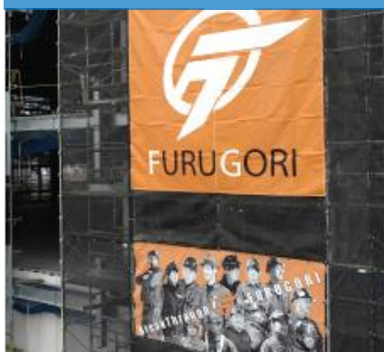
▼突き抜けた足場用PRシート
