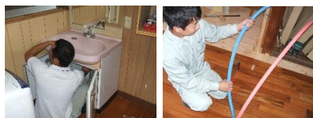
小工事・修理など小回りの利く対応力とスピードは工務店やリフォーム会社が真似できない強みになる
