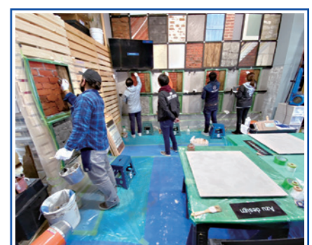
施工技術研修
