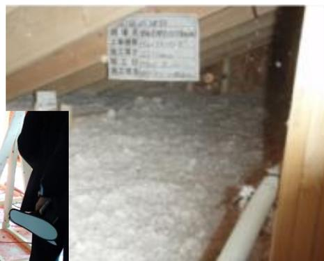
▲天井裏270mmのロックウール。隙間ない施工で断熱性向上
