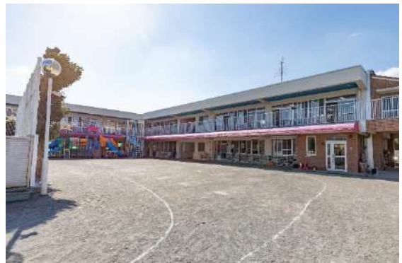
幼稚園部分の園庭・園舎の様子
