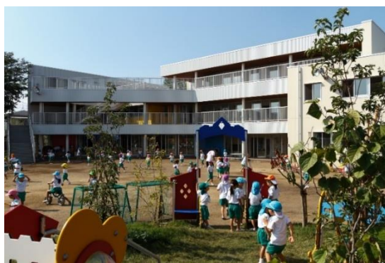
幼稚園部分の園庭・園舎の様子
